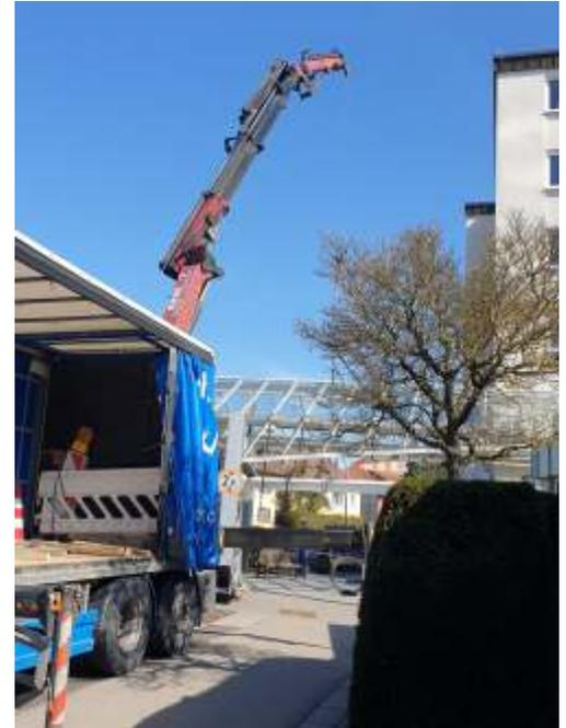
*Der neue Träger wird mit dem Kran auf das Vordach gehoben.*
