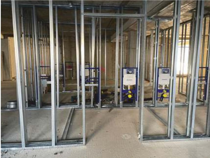
*Im Trockenbau kann man bereits die Sanitärvorinstallationen sehen.*
