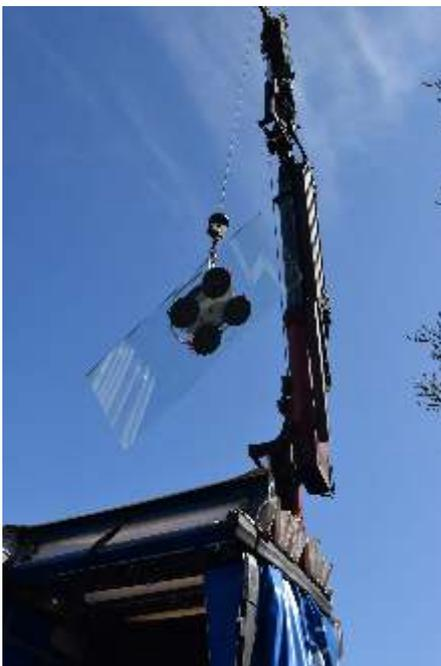
*Eine „fliegende“ Scheibe am Vakuumheber.*
